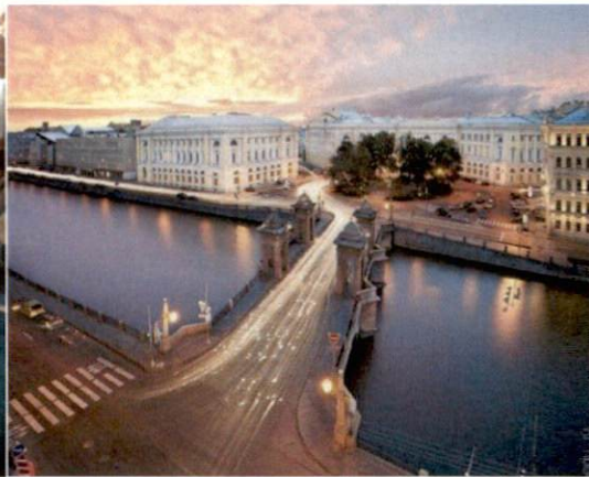
Eine von ca. 34.231 Brücken
