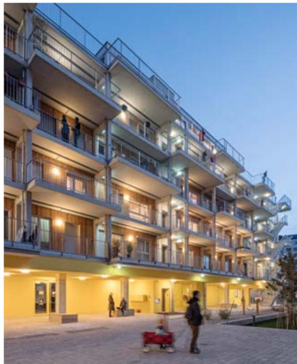
Kompakter Baukörper mit Laubengang, Gleis 21, Wien
