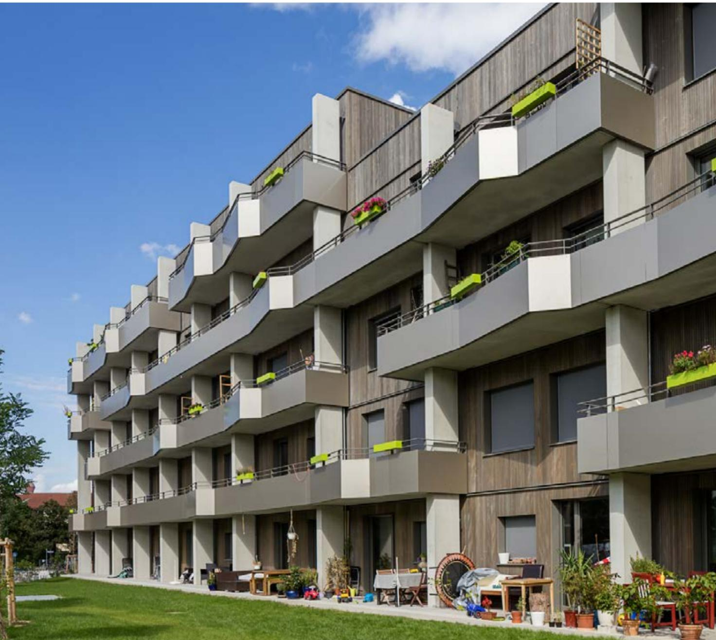
130 Meter langer, fünfgeschossiger Riegel mit vorgehängten Balkonen Richtung Westen
