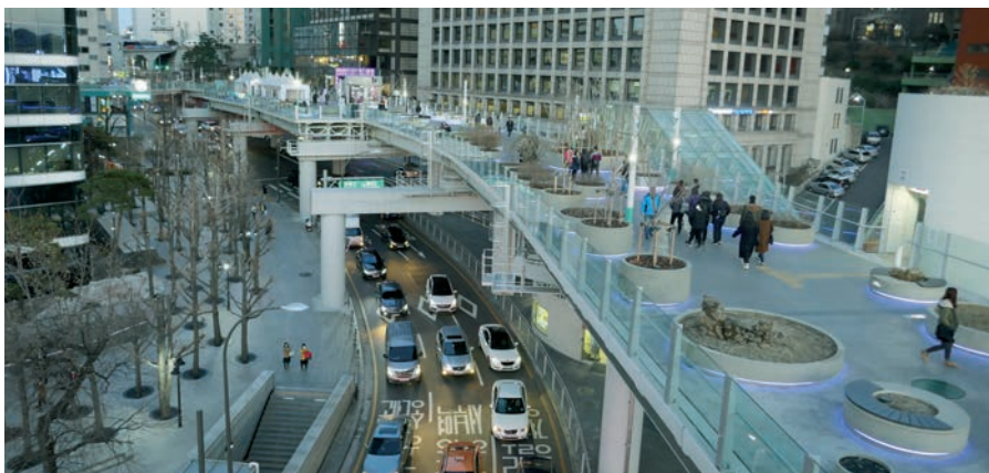
Umnutzung einer Hochstraße zum Fußgänger-Highway
