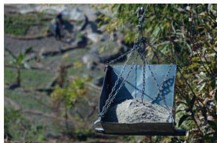
und „telezhka“ aus dem Russischen für „Karre/Schubkarre“. Am flying telezhka befestigt war ein Zugseil, welches auf der Baustelle von einer von zwei Teammitgliedern betriebenen Winde manuell eingeholt wurde. Neben der Errichtung der Massivbauten wurden parallel weitere kleine bis mittelgroße Arbeiten, wie der Bau von Tischen und Bänken oder von Tafeln für den Schulbetrieb, erledigt. Bereits kurz nach Neujahr 2015 konnte das
