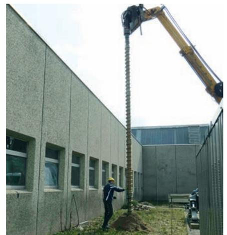
Bohren der Bohrlöcher für die Erdwärmesonden auf dem Gelände der Hochschule Foto: HsKA / KKKU
