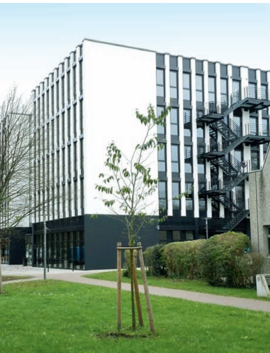
Gebäude von außen
