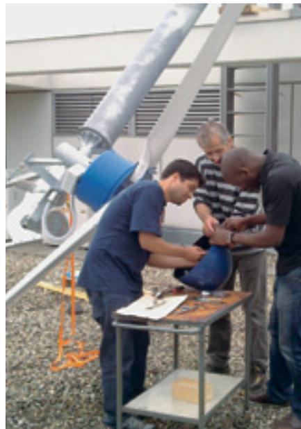
Studierende der HsKA und Laboringenieur Dipl.-Ing. (FH) Hans Wünstel installieren den Rotor eines Windrades auf dem Dach des Gebäudes E.
