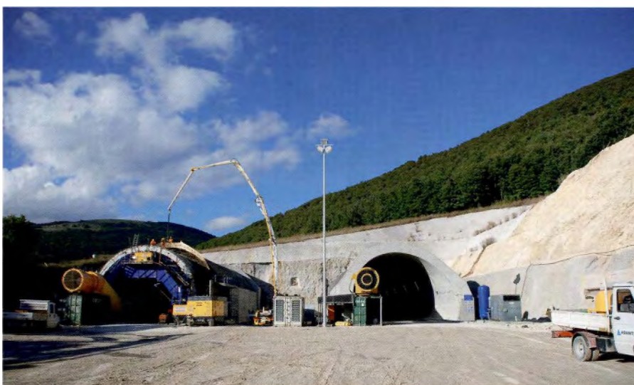
Eingang der Tunnelröhren für die neue Ost-West-Verbindung
