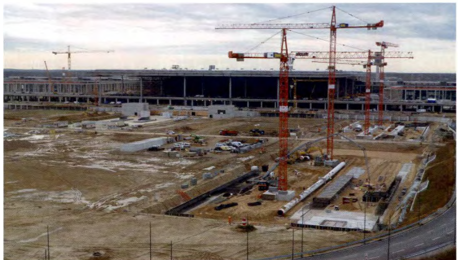
Großbaustelle Neuer Hauptstadtflughafen
