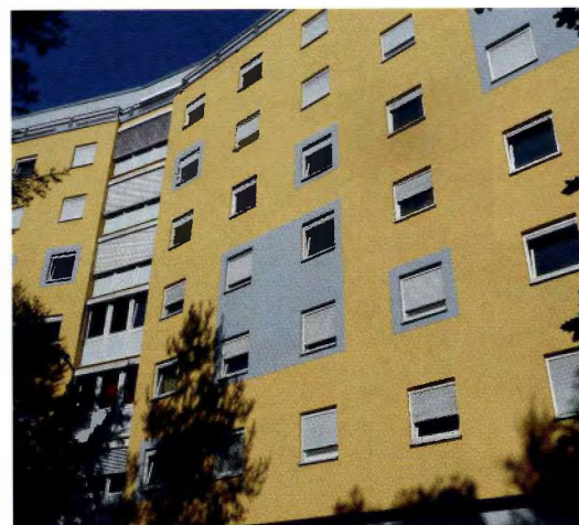
Die neu gedämmte und gestrichene Fassade des Karl-Hans-Albrecht-Hauses
