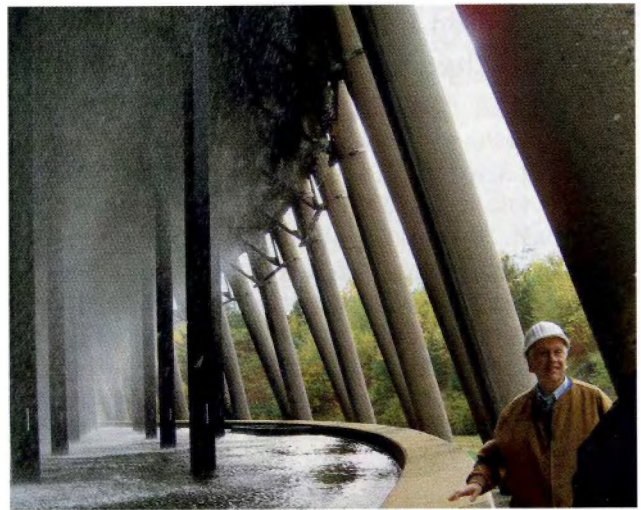
„Eine warme Dusche gefällig?“ – Prof. Brunner vom Freundeskreis EIT am Fuße des Kühlturms im Kraftwerk Bexbach
