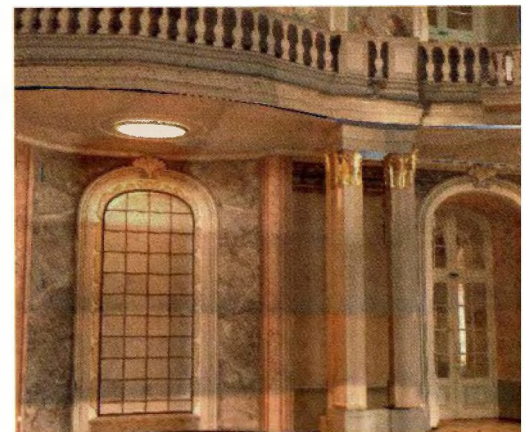
3D-Modell des Asamsaals mit Textur durch die Digitalfotos auf der Grundlage der Videotachymetrie.
