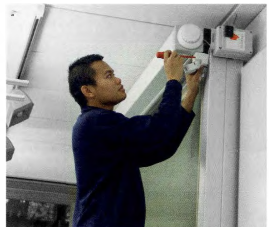
Student der Projektgruppe bei der Installation der Messtechnik
