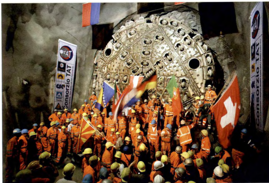
Nach 13.427 Metern und 1.405 Tagen erreichte die Herrenknecht Tunnelbohrmaschine "Sissi" am 6. September 2006 die Multifunktionsstelle Faido im Gotthard-Basistunnel. Mit 2 x 57 Kilometern wird der Gotthard-Basistunnel der längste Eisenbahntunnel der Welt. Vier Herrenknecht-Gripper Tunnelbohrmaschinen mit Durchmesser von 8,83 bis 9,58 Meter sind dabei, insgesamt 75 Kilometer der Basisröhren durch das Bergmassiv zu treiben. Copyright: Herrenknecht AG
