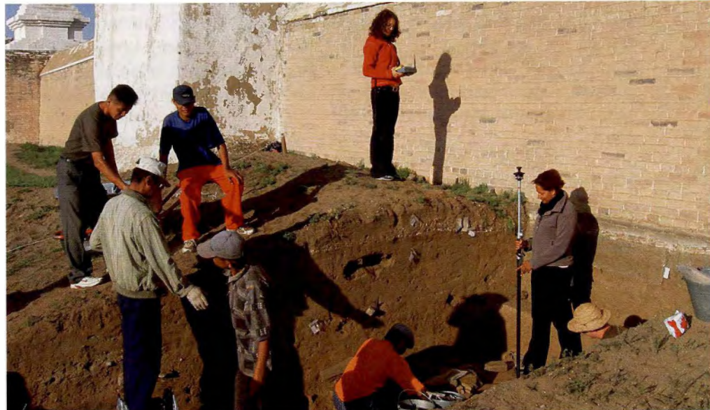
Festlegung eines Rasterpunktes für die Ausgrabung an der Klostermauer (Sarah, rechts am Reflektor, gesteuert durch Juliane, links mit Kontrolleinheit in der Hand, die Robotikstation ist nicht zu sehen)
