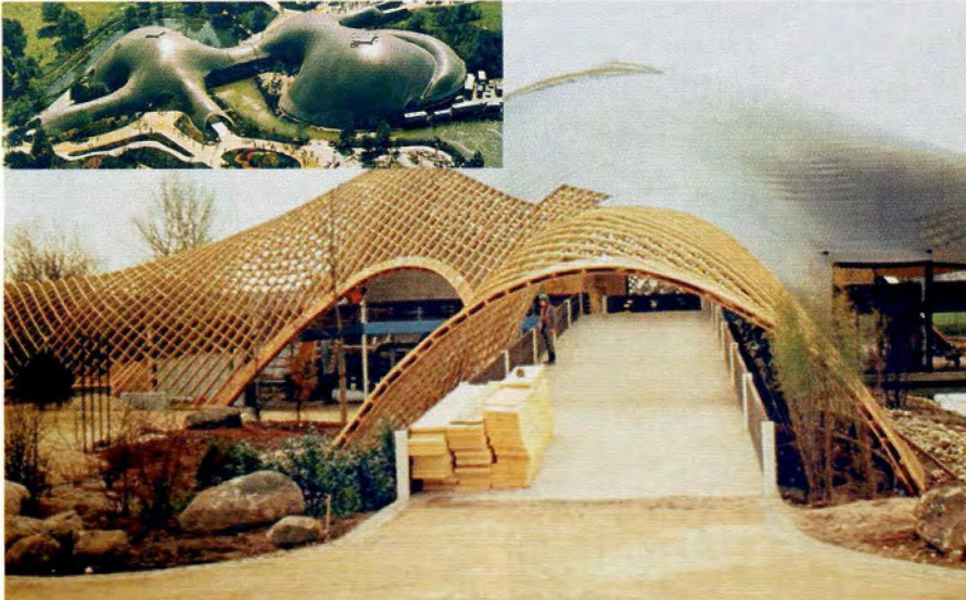
Prototyp der Holzbauhalle
