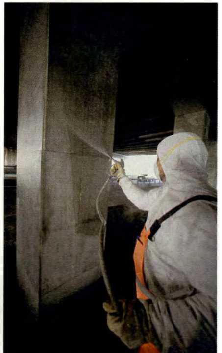
Präventiver Oberflächenschutz durch die Hydrophobierung von Beton
