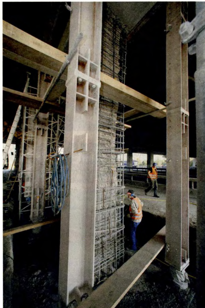
Sanierung der Brückenpfeiler
