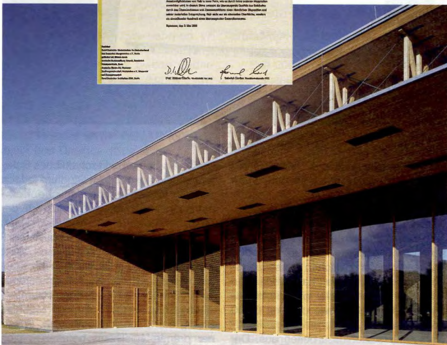
Blick in den Eingangsbereich der Aula – Der Pausenhof vor der Aula wird in 6 m Höhe von der so genannten Gigabox überspannt – einer 37 m weit gespannten Holzkonstruktion. Blick durch die verglaste Stimmseite der Gigabox
