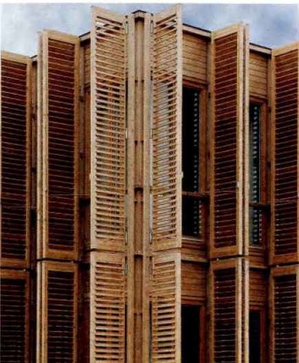
Ecke Fassade mit Sonnenschutzelementen Während die Holzläden im geschlossenen Zustand die Klassenräume verschatten, dienen sie geöffnet als Blendschutz
