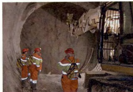
Betoniervorgänge „vor Ort“
