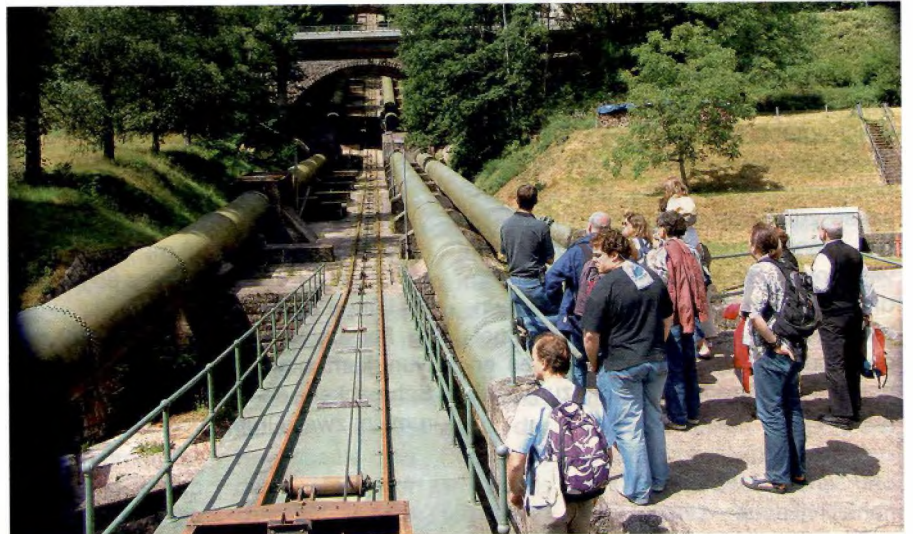
Blick auf die Rohrleitungen zur Schwarzenbachtalsperre
