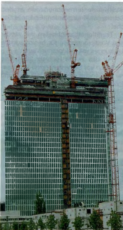
Blick auf die Baustelle des Hochhauses
