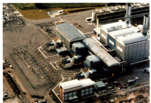
Seabank Powerstation/Großbritannien. Kühlwasseraufbereitung mit ALLDOS-Technik
