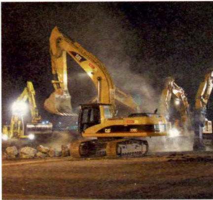
Start-Landebahn Erneuerung, Frankfurt Main
