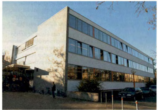
K-Gebäude nach der Aufstockung
