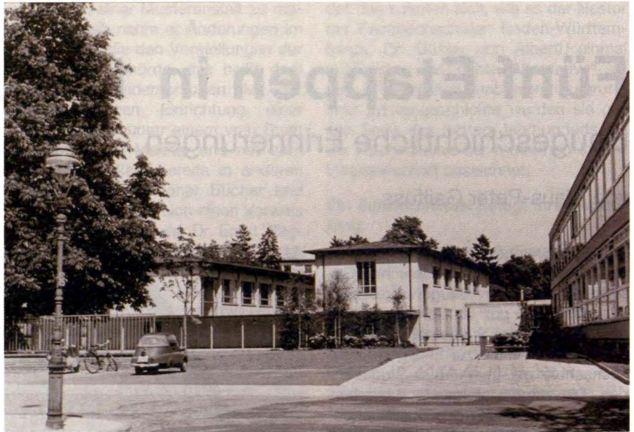
Erweiterungen auf dem Areal „Moltkestraße Süd“, 1954-1961. Blick von Westen. Labor für Elektrotechnik, Labor für Maschinenbau, Kesselhaus (teils verdeckt), Hörsaalgebäude
