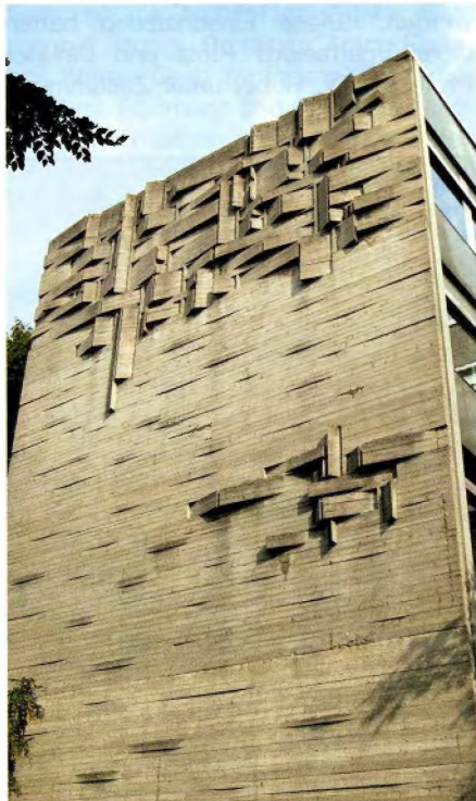
Gebäude Physik und Chemie, Betonplastiken von Bildhauer Erich Hauser, Rottweil
