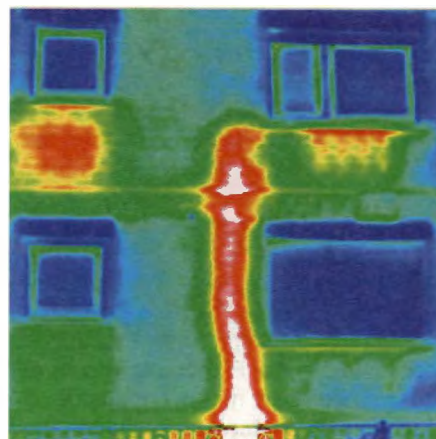
Wärmefoto An der Trift 26
