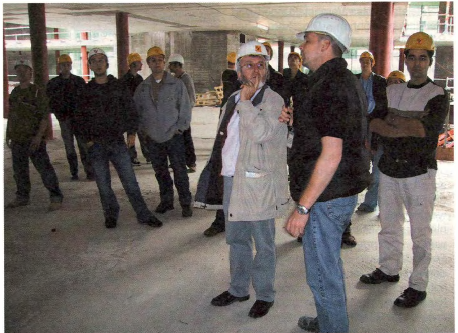
Im Rohbau des Medienzentrum des Axel Springerverlags
