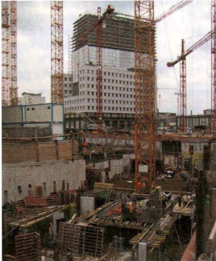
Die Baugrube des Beisheim-Centers
