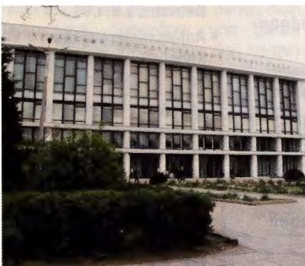
Hauptgebäude der TU Krasnodar
