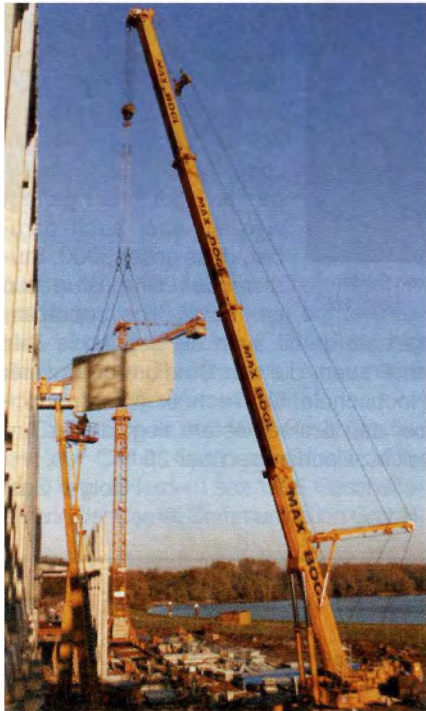
Versetzen der Fassadenelemente mit dem Autokran
