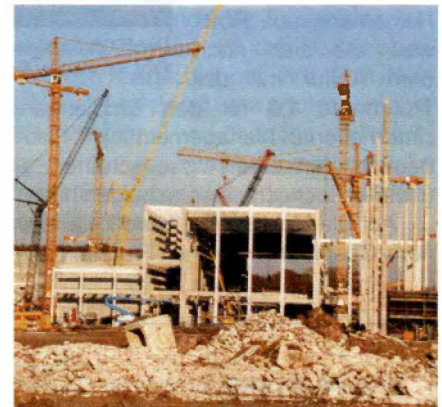
Gesamtansicht der Baustelle „Papierfabrik PM 6“
