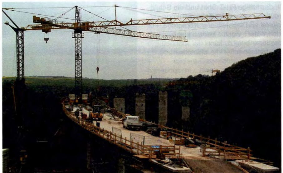
Baustelle der Großheimerstalbrücke im Zuge der L 600
