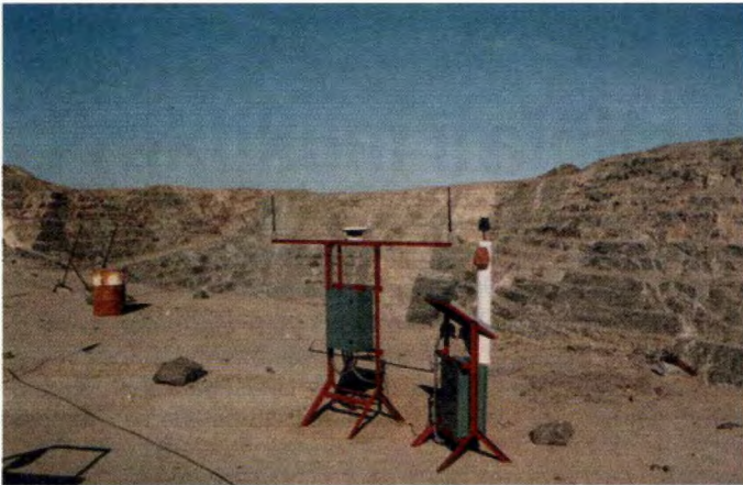
GOCA-Empfänger mit Telemetrie und Solarpanel
