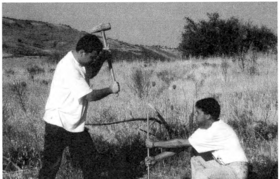
Vermarkungsarbeiten mit Wasserrohren
