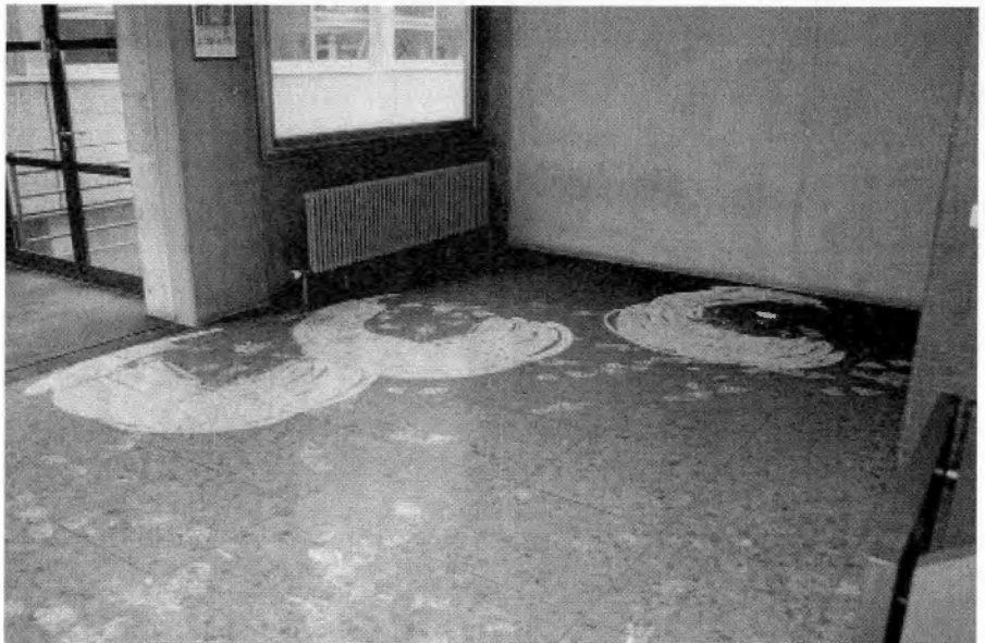
In allen Stockwerken der Gebäude wurden Wischproben genommen
