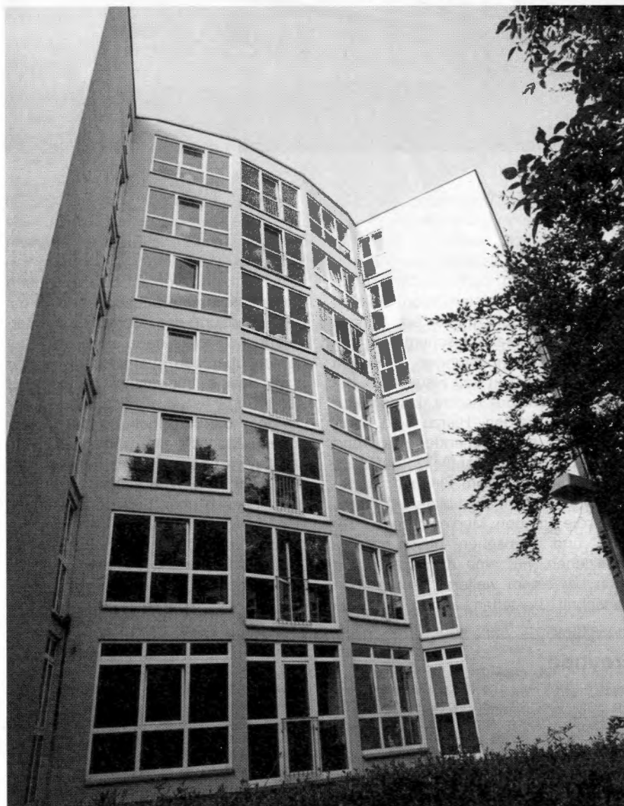
Wohnheim Nordseite: Küchentrakt - Küche mit Aufenthaltsraum
