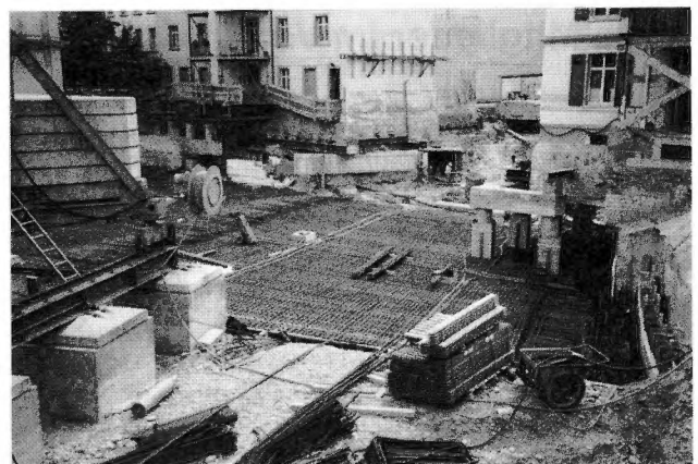
Baustelle N2 Nordtangente in Basel
