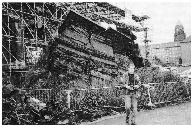
Die eingerüstete Frauenkirche in Dresden. Im Vordergrund der herabgestürzte Eingangsrissalit
