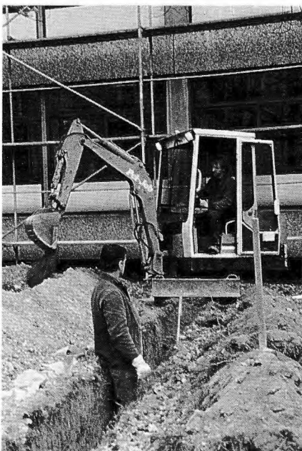
Einrichtung eines Kommunikationsnetzes Grabarbeiten für die Rohrverlegung
