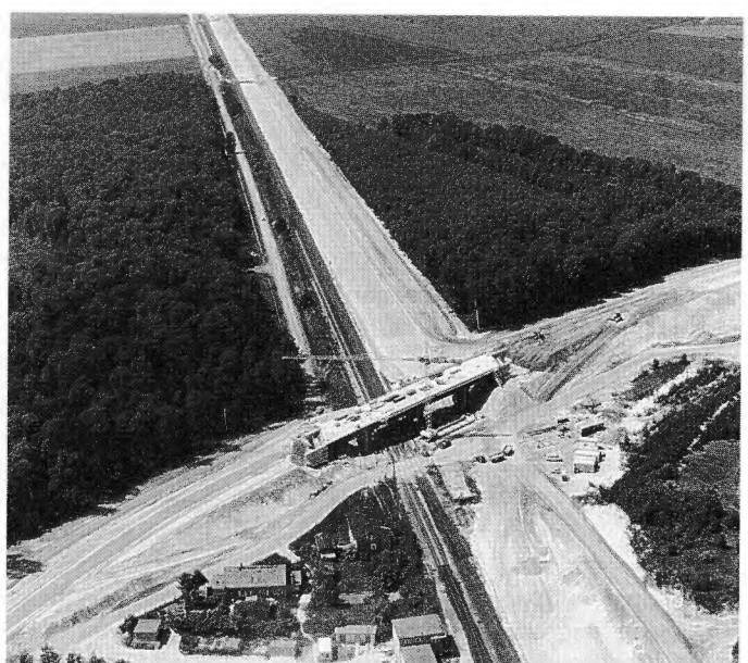
Ein 86 m langes "Baustellenband" zieht sich - wie hier bei Schönhausen - durch das Land Sachsen-Anhalt
