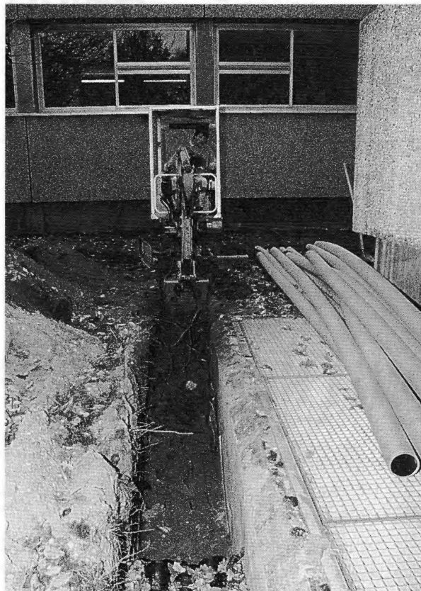
Die Verlegung der Leer-Rohre, in die später Leitungen aus Glasfaser eingezogen werden Foto: LUZ
