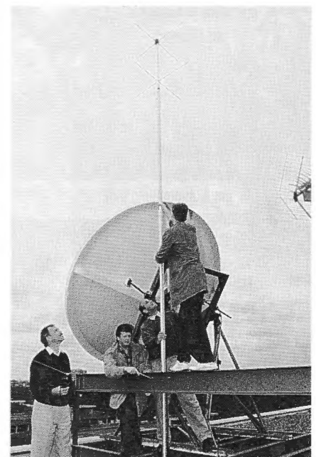
Installation einer Antenne für den Empfang von "niedrig" fliegenden Wettersatelliten auf dem Bauingenieurgebäude. V.l.n.r.: Prof. W. Ritzert, P. Pirogow (N-Werkstatt), Prof. Dr. S. Ruchadse und H. Nuss (N-Werkstatt)
