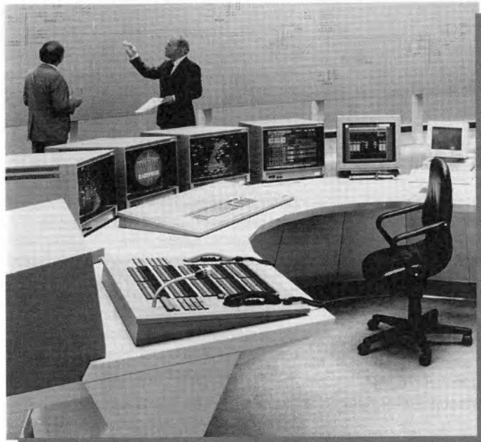
Die Karlsruher Fächerwarte sichert die Stromversorgung im Bereich der Badenwerk AG
