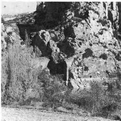
Blick in die Schlucht samt vorgelagertem alten Wegeverlauf mit der zerstörten Brücke
