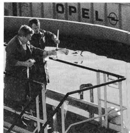
Adam Opel AG, Werk Kaiserslautern Werkseigene Abwasseraufbereitungsanlage
