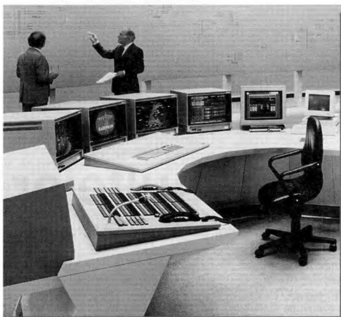
Die Karlsruher Fächerwarte sichert die Stromversorgung im Bereich der Badenwerk AG
