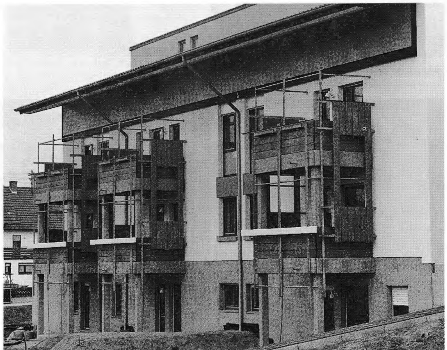
Wohnanlage "Tuchbleiche", Balkonkonstruktionen Feldseite
