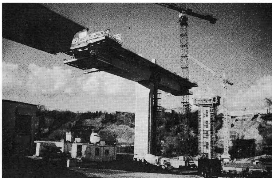
Cantilever bridge, Teil des Western Parkway Project Arbeitsgemeinschaft DYWIDAG/Irishenco Foto: W. Pf.
