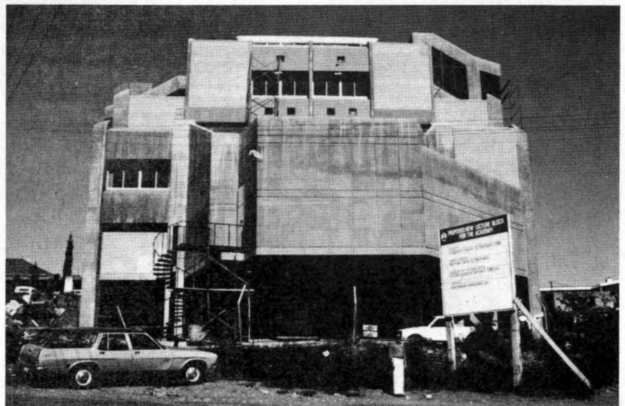
Rohbau des hochmodernen Vorlesungsgebäudes der ACADEMY.
