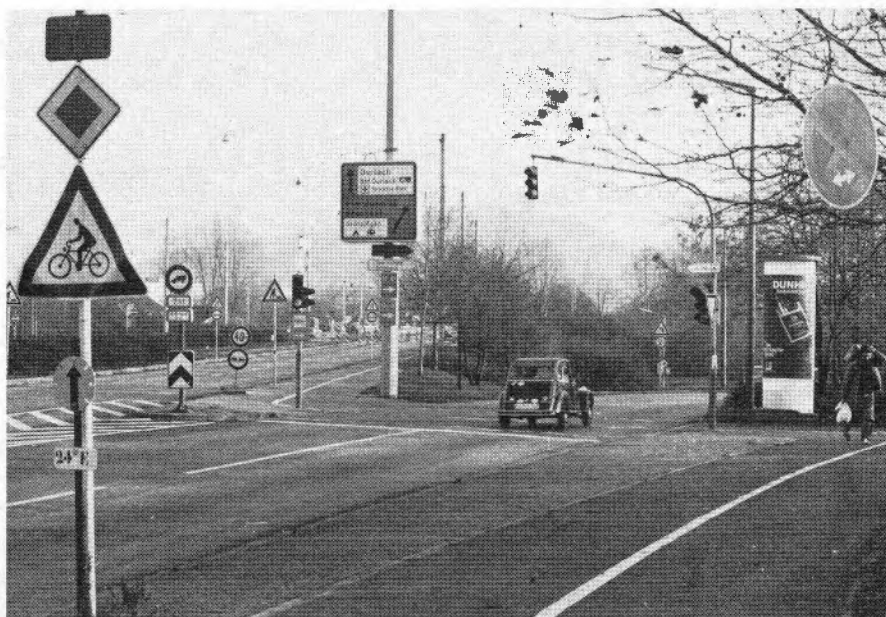
Unfallschwerpunkt ist der Übergang des südlichen Radweges der Durlacher Allee über die Ausfahrt der B 10 in Richtung Grötzingen. Von insgesamt 31 Unfällen in den letzten sechs Jahren ereigneten sich hier 15 Unfälle mit Beteiligung von Radfahrern.
