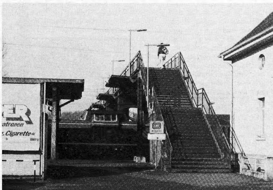
Problempunkt Fußgängerbrücke über die B 10 und den Bahnhof Durlach. Im derzeitigen Zustand ist die Benutzung für Radfahrer unzumutbar. Foto: Kühn
