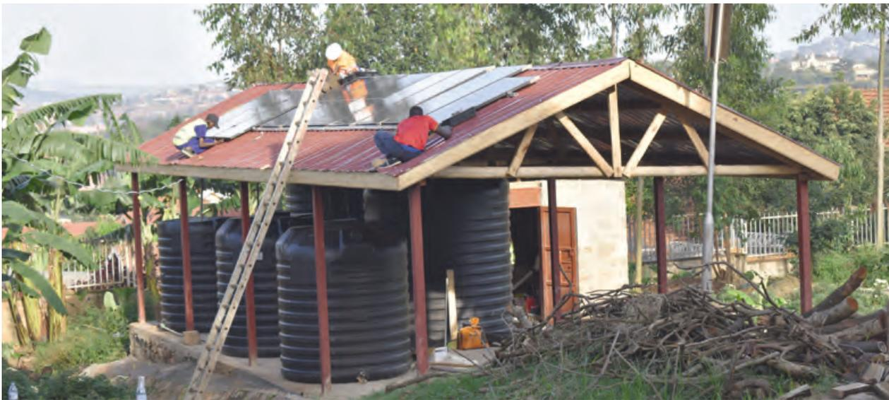
Abb. 1: Photovoltaik-Anlage mit neuartigen stationären Energiespeichern aus sog. Superkondensatoren („Supercaps“) (Foto: Jan Hoinkis)
