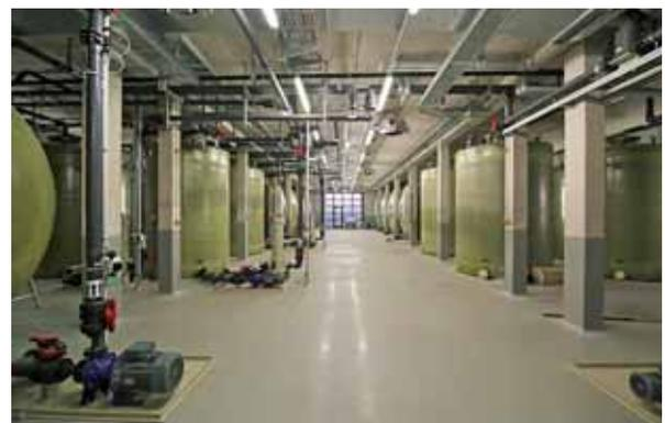
Abb. 4: Tankhalle der am Fraunhofer ICT installierten 2 MW / 20 MWh Vanadium-Redox-Flow-Batterie (Foto: Fraunhofer ICT)
