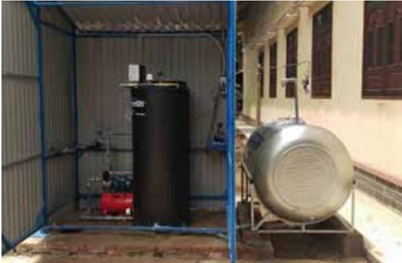
Abb. 6: Erste Pilotanlage zur in-situ-Arsenentfernung in der Provinz An Giang, Mekongdelta, Südvietnam (Foto: Felix Leidinger)
