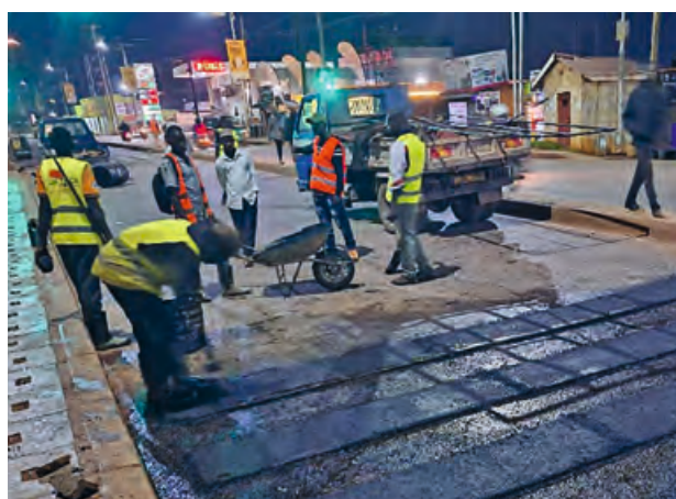
Abb. 3: Bauarbeiten im Rahmen des Living Labs in Kampala: Markierungsarbeiten und bauliche Maßnahmen zur Erhöhung der Verkehrssicherheit für Fußgänger:innen an der Sir Apollo Kaggwa Road. Quelle: CAMA / Hochschule Karlsruhe
