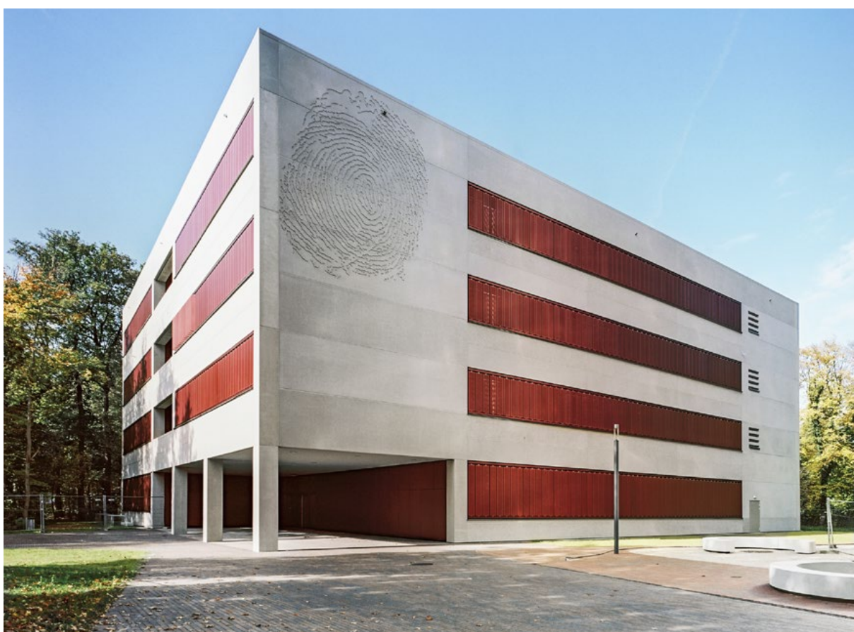
Die Außenarbeiten am Neubau des Gebäudes N sind so gut wie abgeschlossen
