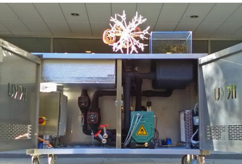
Blick in das Innere und damit auf die Hochtemperaturwärmepumpe (Foto: Dennis Lerch)
