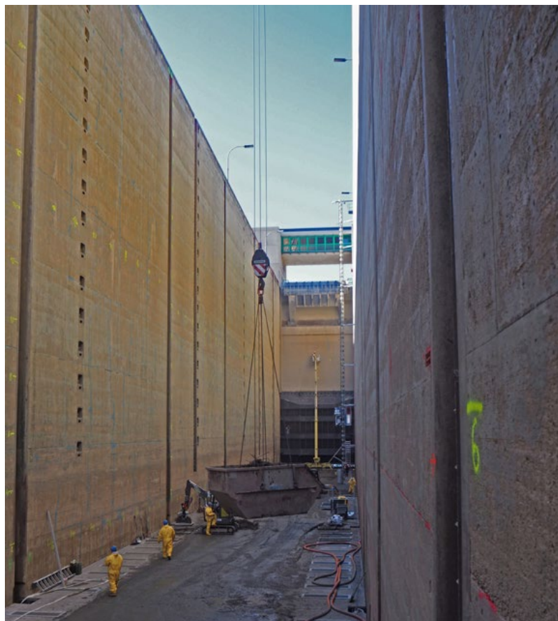
Revisions-Trockenlegung der Schleuse Hilportstein des Main-Donau-Kanals (Foto: Simon Weiler)
