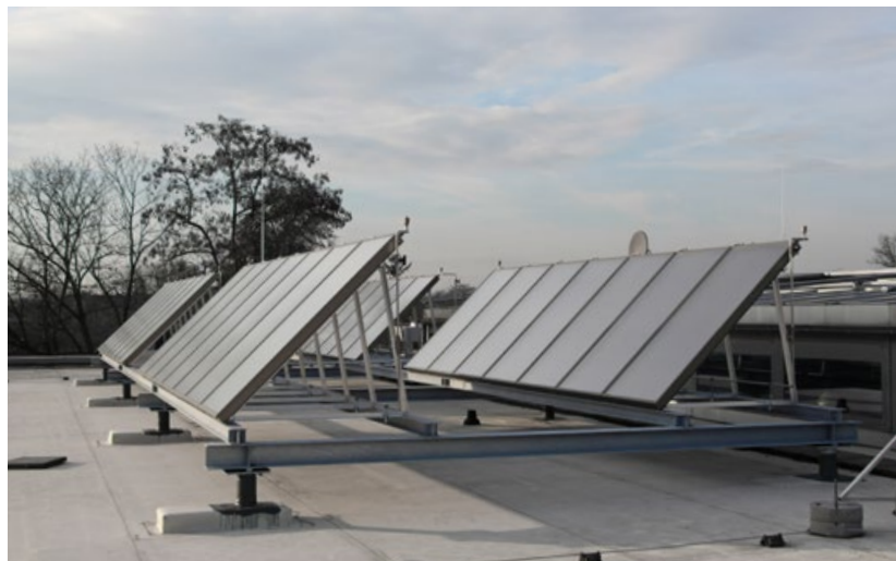
Solare Klimatisierung: Flachkollektoren auf dem Dach des Gebäudes K (Foto: Adrian Bürger)
