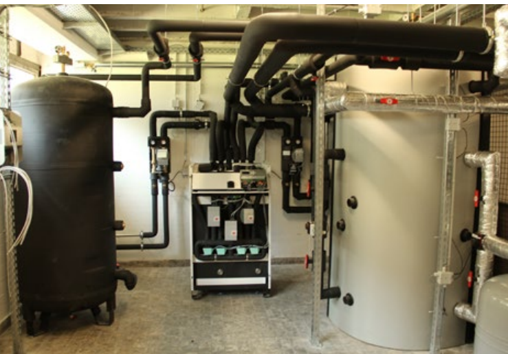
Anlagenkomponenten der solaren Klimatisierung, v. l. n. r.: Kältespeicher, Adsorptionskälteanlage, Wärmespeicher (Foto: Adrian Bürger)
