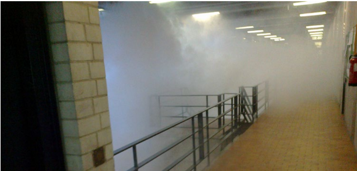
Mit einer gezielten Verrauchung im Gebäude LI wurden von der Feuerwehr die dortigen Sicherheitseinrichtungen überprüft (Foto: Andreas Erdmann)
