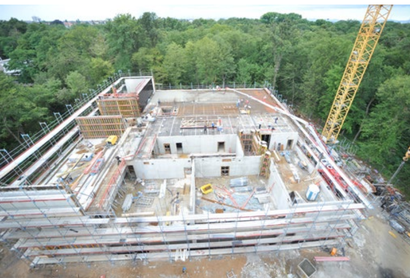
An der Willy-Andreas-Allee westlich des Gebäudes B wird ein neues Gebäude auf dem Campus gebaut
