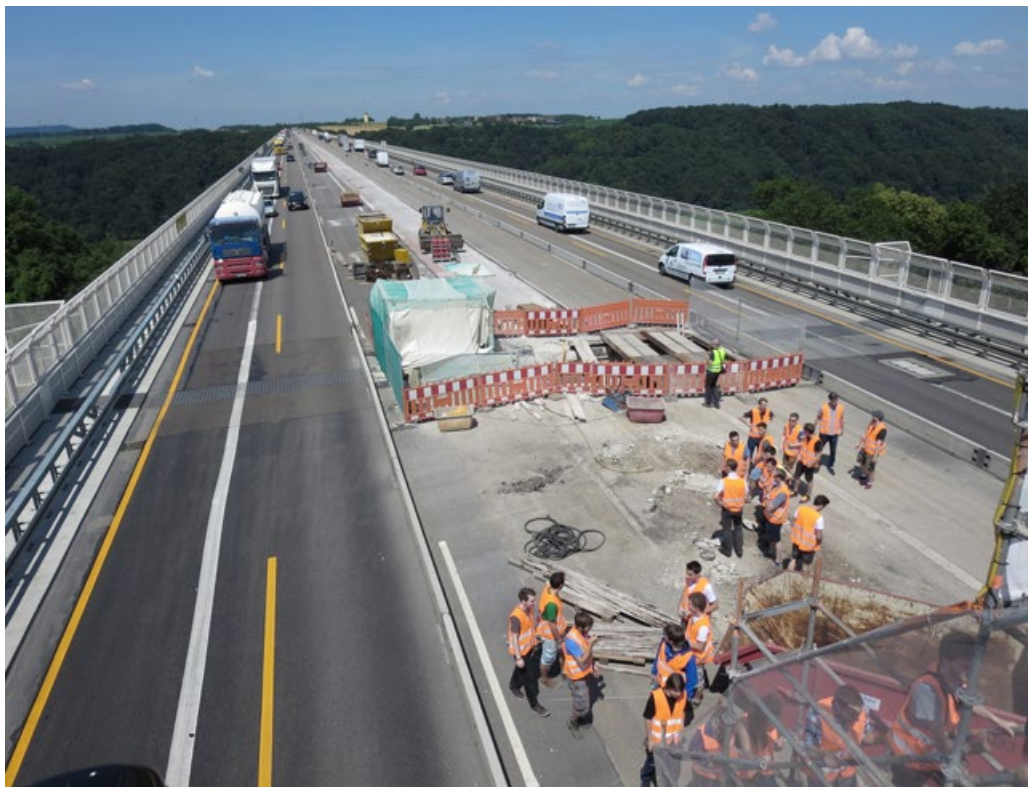
Studierende des Studiengangs Infrastructure Engineering auf der Sanierungsbaustelle Kochertalbrücke
