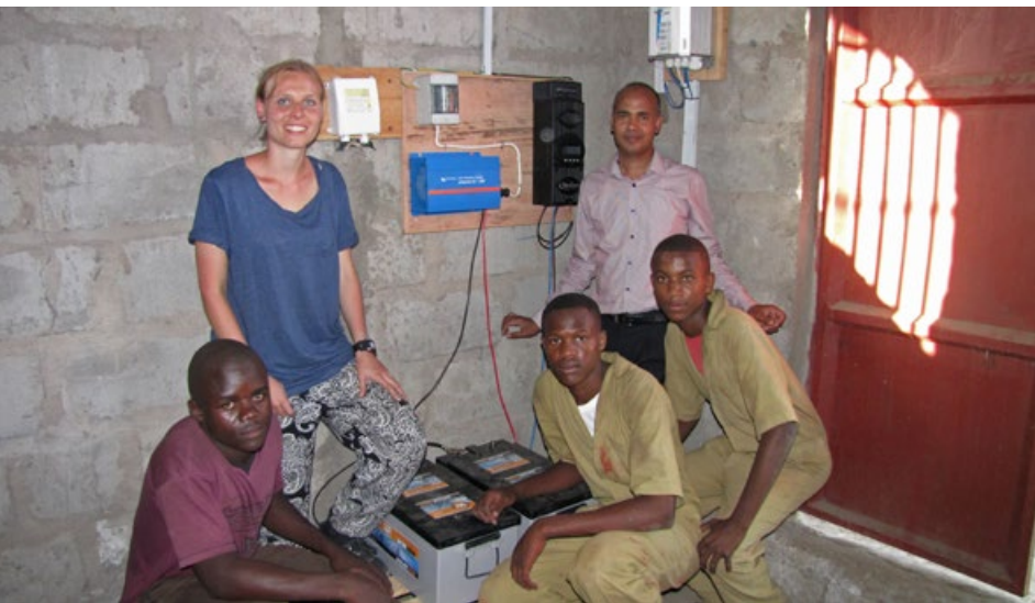
Bei der Inbetriebnahme der Anlage zur nachhaltigen Trinkwasseraufbereitung in Tansania: Pia Britsch, die ihre Bachelor-Thesis in diesem Projekt verfasste, und der verantwortliche Projektingenieur Dr. Shamim Deowan mit seinem Team
