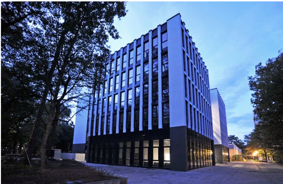
Das neue Steinbeis-Haus auf dem Campus der Hochschule Karlsruhe ist auch ein architektonisches Schmuckstück
