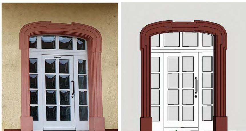
Abb.1: Eingangstür des Rathauses in Realität (links) und im BIM-Modell als Revit-Familie (rechts)
