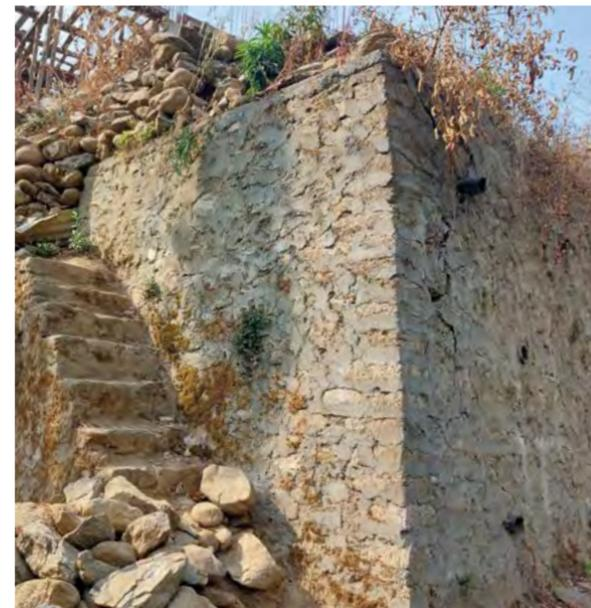
Die Stützmauer zur Sicherung des Geländes
